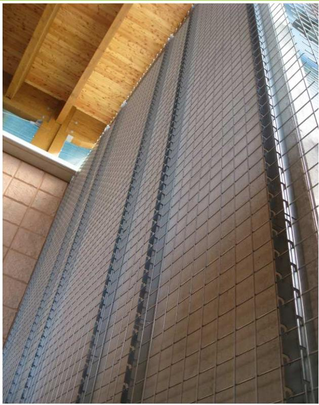
Montanti e rete elettrosaldata posata su muro portante/struttura metallica autoportante
